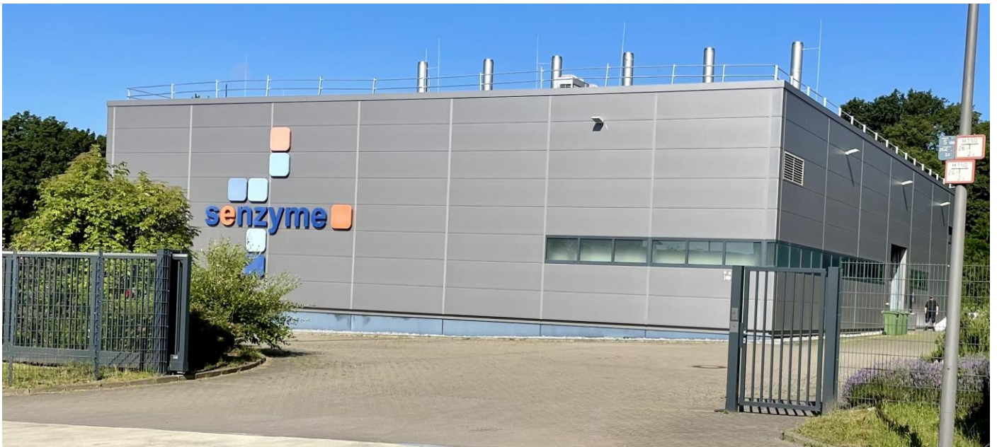
Foto: VH, ca. 40x70x12 (m), erstes Produktionsgebäude an der Gierlichstraße
