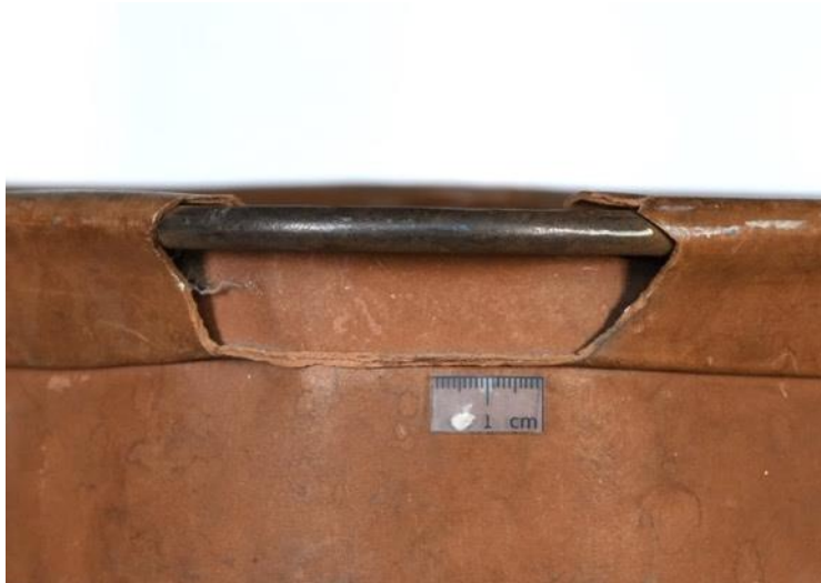
Abbildung 7 Wickelfalz um Rundeisenstange
