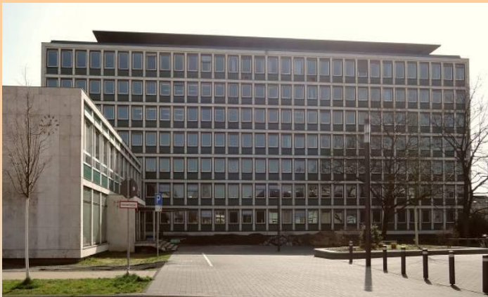
Das DAG-Verwaltungsgebäude von 1956
