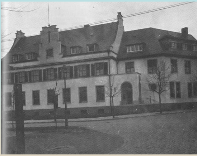
Das Postamt: 1925 erbaut, heute noch an gleicher Stelle
