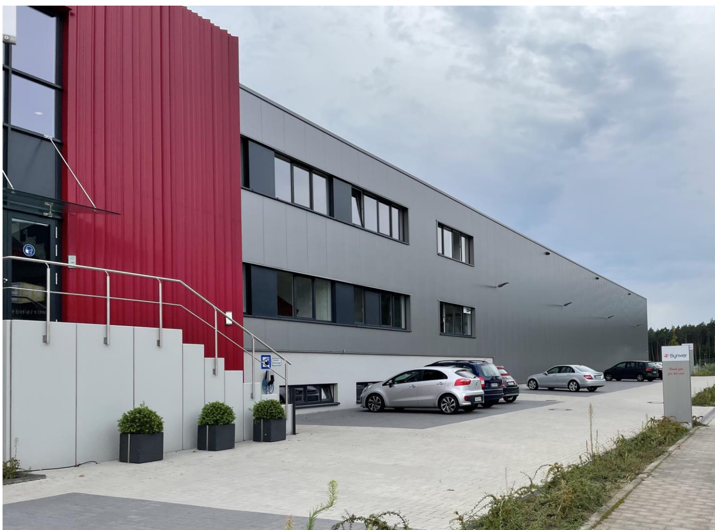
Synwer GmbH von Nordosten, Foto: VH
