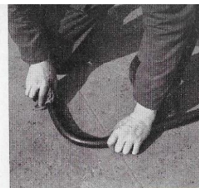
Biegen des erwärmten Dynalenrohres zum Krümmer ohne weitere Hilfsmittel.
