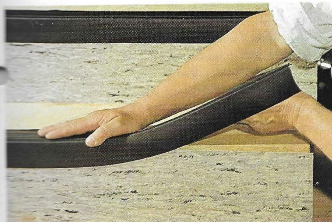
Anlegen der vorher mit Kleber eingestrichenen MIPOLAM-Treppenkante
