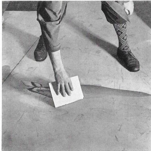
Abb 6: Aufspachteln des Klebers auf den Estrich
