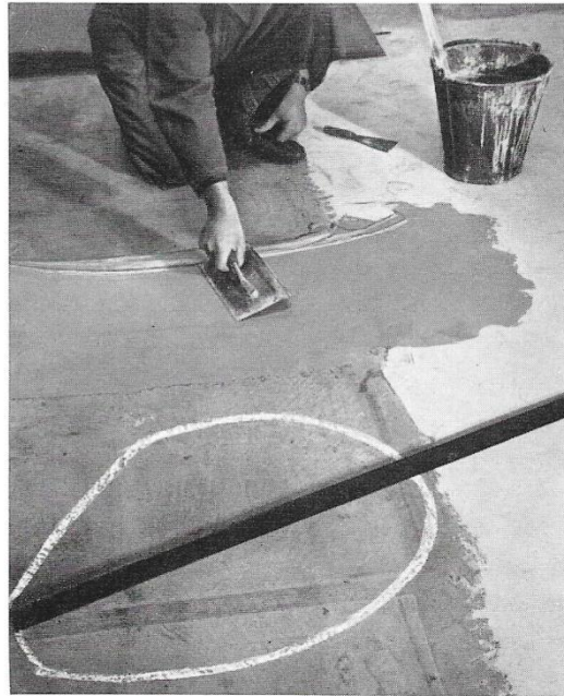
Abb. 1: Abspachteln des Unterbodens bzw. Untergrundes oder Estrichs. Stärkere Unebenheiten werden vor der Spachtelung durch Lehre festgestellt und mit Kreide markiert.
