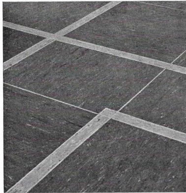
Oberseitig verschweißte Verlegung
