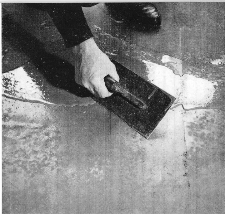
Abb. 5 Abspachteln des Unterbodens bzw. des Untergrundes oder Estrichs.
