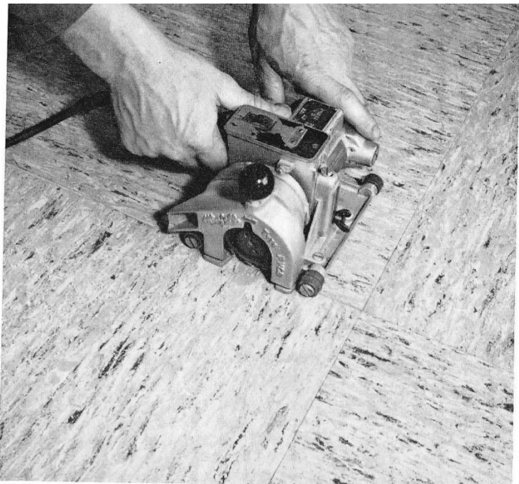
Abb. 34 Einfräsen der Schweißfugen.
