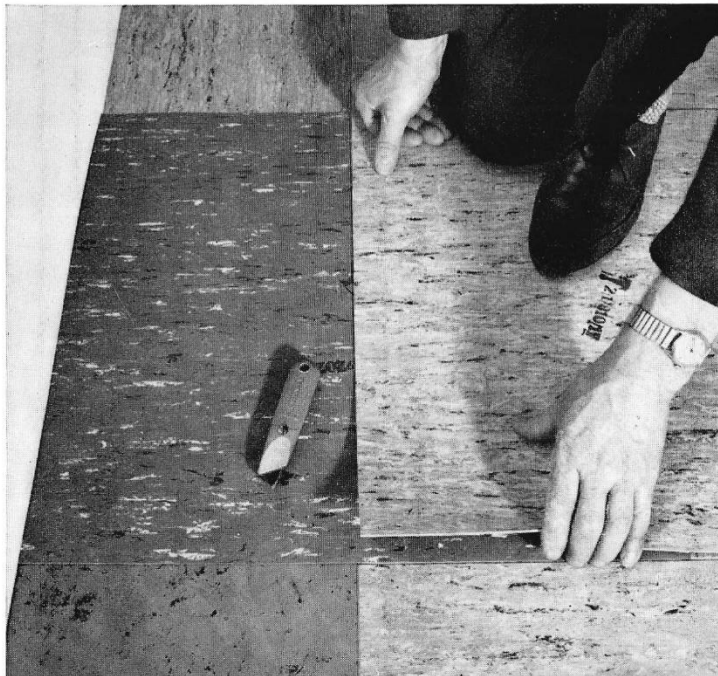
Abb. 21 u. 22 Einlassen und Schneiden der Randfliesen
