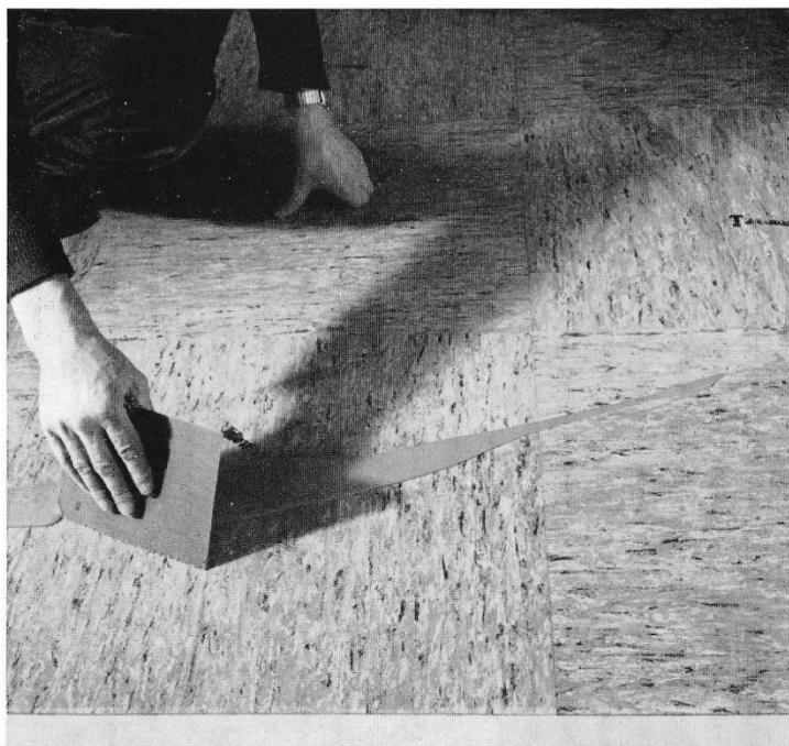
Abb. 25 Aufspachteln des Klebers auf die Rück- seite der Fliesen (wobei mehrere Fliesen zusammengelegt werden).
