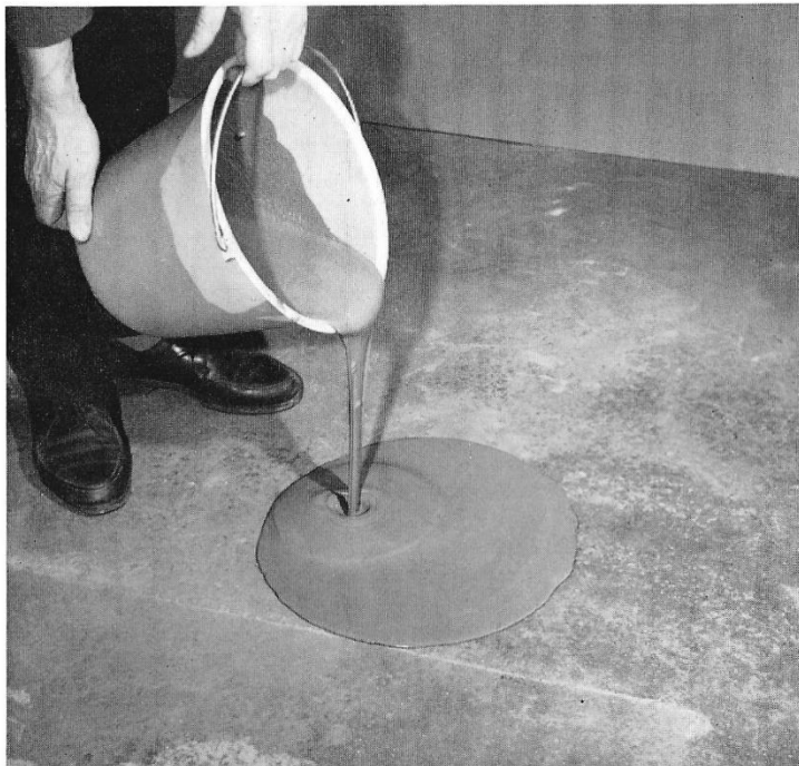
Abb. 3 Die Spachtelmasse wird zähfließend aufgetragen
