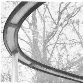
Bekleiden von Krümmern, Krümmungshalbmesser 50 mm
