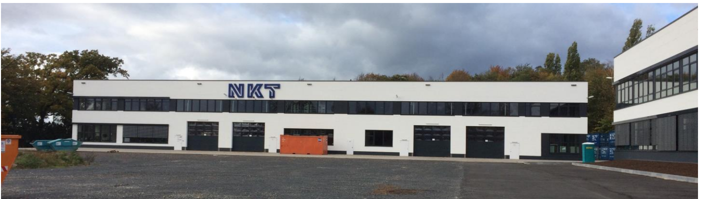
Foto: VH, Ansicht von der Gierlichstraße, Länge: etwa 90 m
