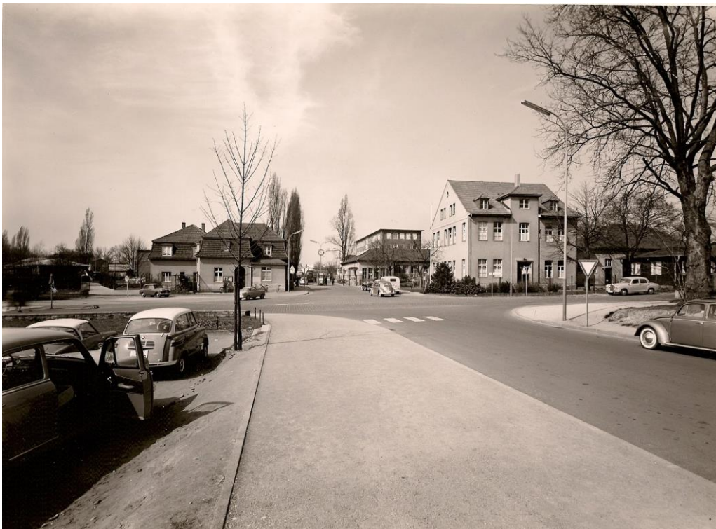
Blick auf Tor I, Kaiserstraße, vor dem Neubau (1960)
