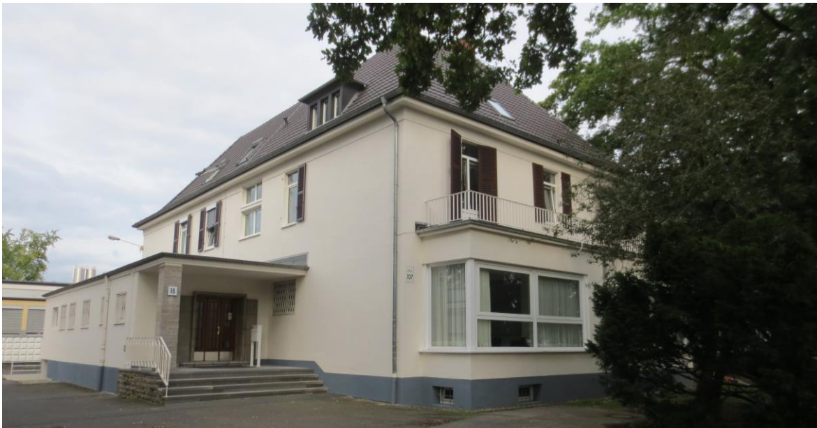
Ansicht von der Mülheimer Straße
