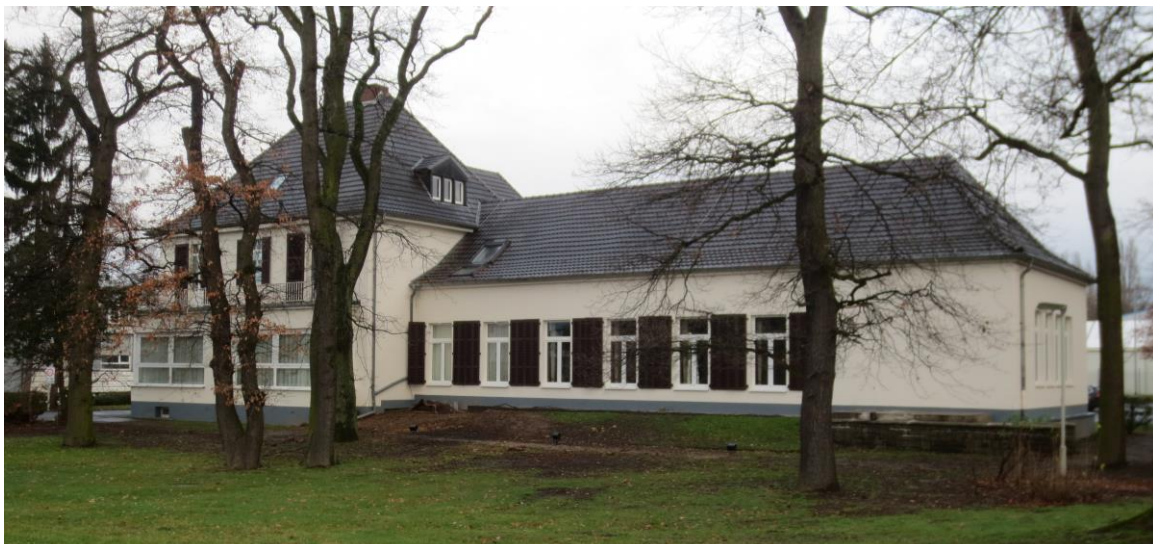
Ansicht von der Mülheimer Straße
