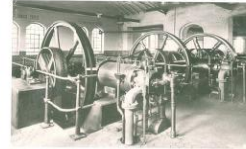
Ein Blick in den Maschinenraum des Aggerwerks
