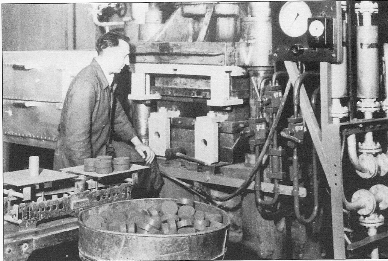
Troisdorf, Rheinisch-Westfälische Sprengstoff AG, Eugen Walsdorf an der 600-Tonnen-Pressse mit Rohlingen zur Herstellung von Volksempfänger-Gehäusen, 1935.
