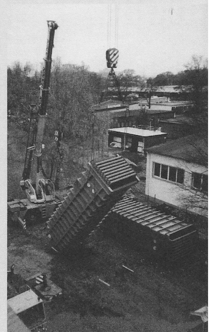
Der erste der beiden Auswaschbottiche wird zu seinem späteren „Arbeitsplatz“ gehievt.
