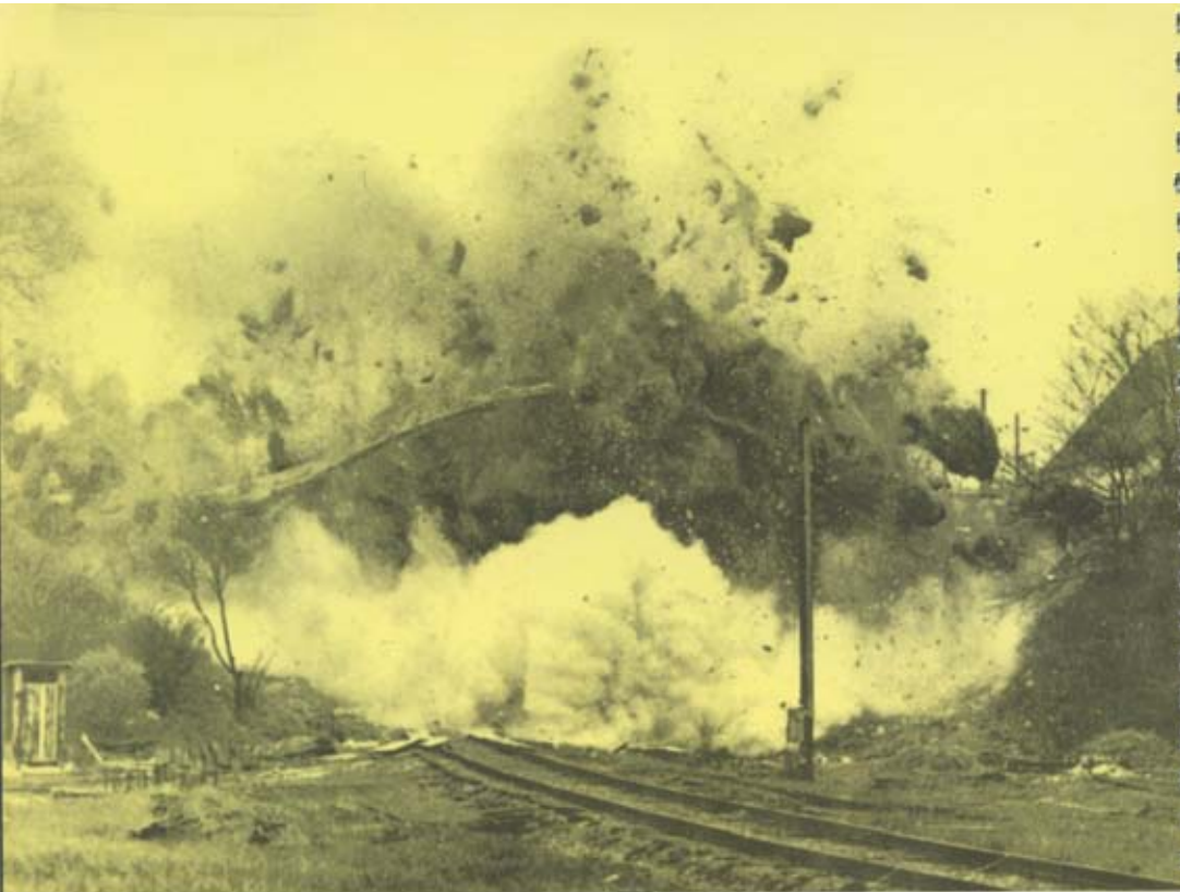
Sprengung einer Stahlbetonbrücke mit Millisekündenzündern
