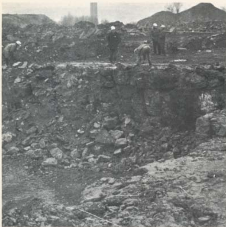
Vorbereitung zur Sprengung
