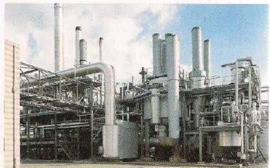
Anlage zur Herstellung von Phthalsäureanhydrid (PSA) bei N.V. VFT S.A. in Zelzate/Belgien. Phthalsäureanhydrid dient zur Herstellung von Phthalsäureestern und Alkydharzen sowie von Farbstoffen und Pigmenten.
