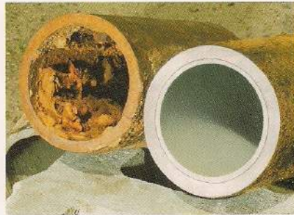
Sanierung von Rohrleitungen: Wasserleitung vor und nach der Sanierung durch Zementmörtelauskleidung.
