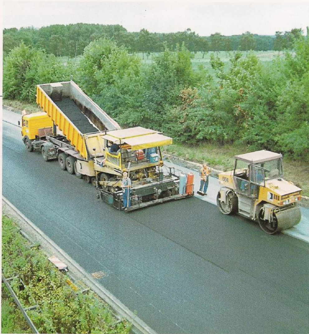
Beläge und Abdichtungen im Hoch- und Ingenieurbau: Brücke Donaustauf mit einem Dünnbelag auf Reaktionsharzbasis im Gehwegbereich. ▶
