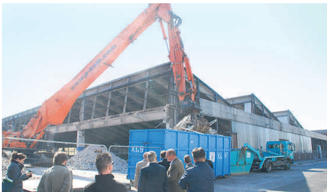
Nicht plattmachen, sondern verwertbar wieder aufbereiten: PVC-Recycling von Fenstern und Bodenbelägen aus der 1961 erbauten Sheddachhalle und dem nebenan liegenden Bürogebäude. Theoretisch, so erklären Fachleute, könne dieser Kunststoff aus Troisdorf noch 200 Jahre zum Einsatz kommen.
