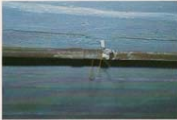
Bild 17: Noch vorhandenes PVC-U-Rohr in Bitterfeld, Parkstraße 18, aus der bis 1991 betriebenen und dann ersetzten Installation.
