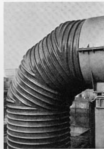
Abb. 24 Segmentbogen, geschweißt mit GFP verstärkt
