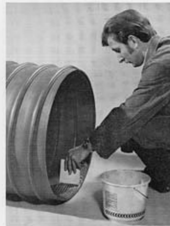
Abb. 7 Auftragen des Klebers in ein Rohrende * / DEGUSSA, HANAU
