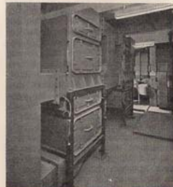
Bild 19 Luftfilter aus Trovidur zur Abscheidung radioaktiver Verunreinigungen
