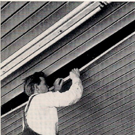
Einrasten der Profile (starres System)
