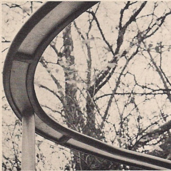
Bekleiden von Krümmern, Krümmungshalbmesser 50 mm
