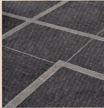
Oberseitig verschweißte Verlegung
