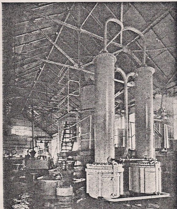
Anlage zur Herstellung von Natriumazid
