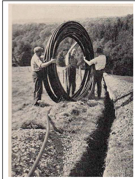
Verlegung eines PE-Rohrs, ND 10
