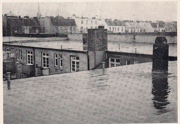
Abb. 3. Dachfolien aus Weich-PVC
