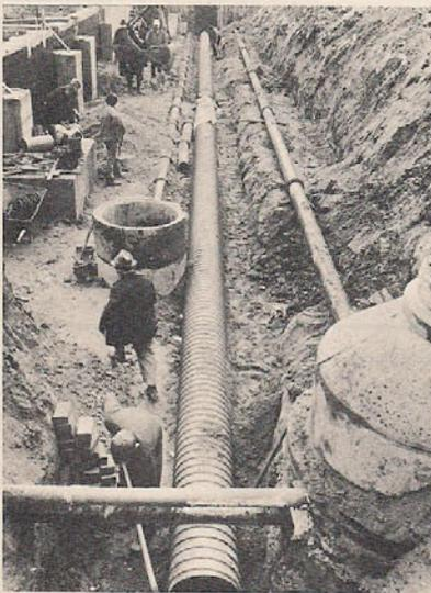
Bild 1 · Ein Industriebetrieb bei Niederkassel, bei dem stark korrodierende Abwässer anfallen, wählte für diese Abwasserleitung Stegrohre aus PVC hart. Die Leitung hat einen Durchmesser von 500 mm
