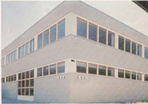
Bild 13. Mit orange Color-Fenstern ausgestattetes Industriegebäude.
