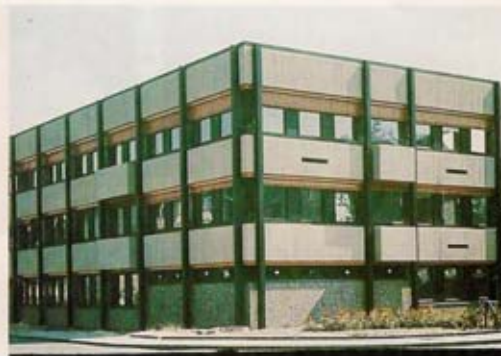
Bild 12. Verwaltungsgebäude mit braunen Trocal-Color-Fenstern.
