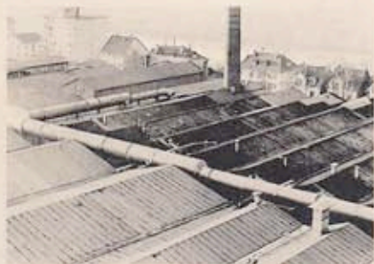
Bild 5: Absaugung in der Kunstfaserindustrie (Trovidur-®-Spiralrohr) bis NW 2500 Werkfoto DN
