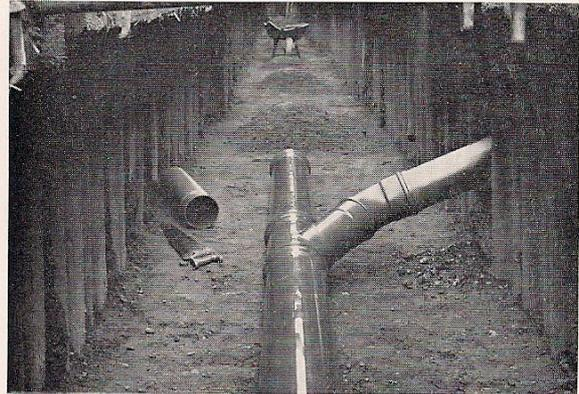
Bild 9: Verlegung von Kanalisationsrohren
