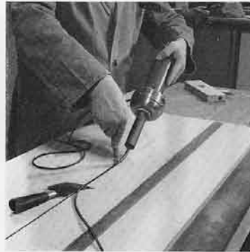
Unterseitiges Verschweißen von DYNAPLAN T und Beschneiden des Schweißdrahtes
