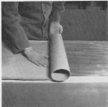
Abrollendes Auflegen von DYNAPLAN T beim Verkleben auf nicht saugendem Untergrundmaterial
