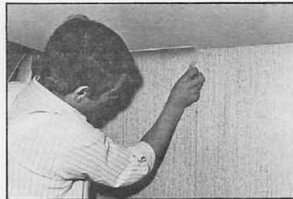
aufzutragen, damit eine wirklich einwandfreie Haftung gewährleistet ist. Nach dem Kleberauftrag wird die erste Bahn lotrecht auf die Wand gebracht (ein Verschieben oder Korrigieren ist noch möglich) und von oben nach unten und seitlich mit einem Kunststoffspachtel gut angerieben.
