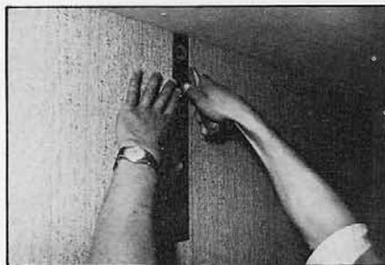
Bei Innenecken ist der Belag zu stauchen und bei Außenecken gedehnt um die Ecken herumzuziehen.
