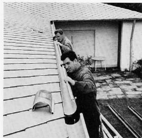
Einlegen der Rinne beim Auswechseln gegen eine alte Zinkrinne
