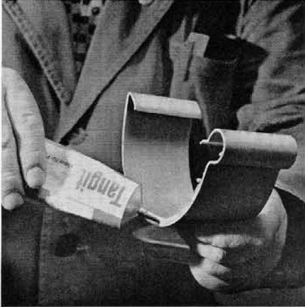
Auftragen des Klebers an der Rinnenkupplung
