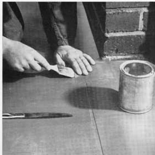
Einbau eines Folieneckstückes an einer Außenecke
