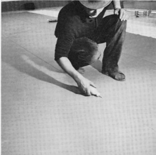
Auftragen der Flüssigfolie an der Foliennaht
