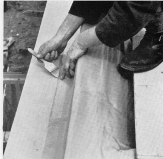
Ausführen der Verklebung im Reaktivierverfahren durch Spezial-Verdünner
