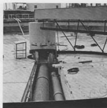
Abb. 28 Dynadur®-Kanalstegrohre DN 700 und DN 1000 als Zu- und Ableitung in einer Kläranlage
