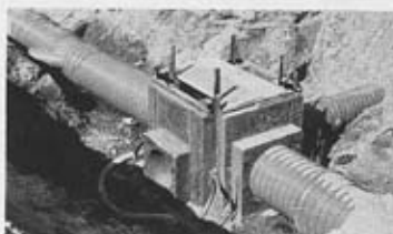
Abb. 27 Kanalstegrohre DN 1000 mit gegenüberliegender Einmündung von Rohren DN 500 in einen Revisionsschacht aus Polybeton
