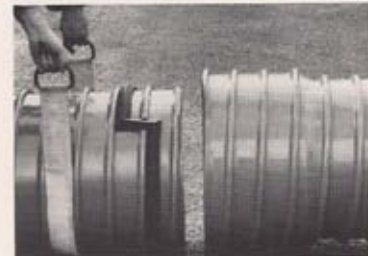
Abb. 21 Montage einer Steghrohrmuffe DN 500
