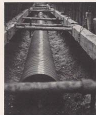
Abb. 23 Verlegung im Verbau, DN 500, in etwa 3,5 m Tiefe mit montierten Abzweigen
