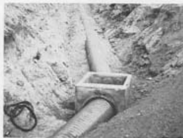
Abb. 24 Dynadur®-Kanalstegrohre DN 800 in geböschtem Graben mit eingebautem vorgefertigtem Betonschacht
