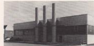
Abb. 33 12 m hohe Abluftkamine eines Galvanisierbetriebes aus Trovidur®-Spiralrohr DN 1250
