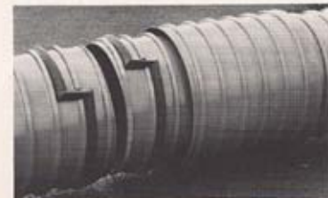
Abb. 22 Einbau einer Überschiebemuffe
