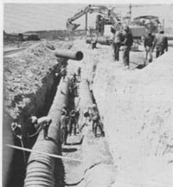
Abb. 25 Doppelverlegung von Dynadur®-Kanalstegrohren DN 1000 in breitem Graben mit 5 m Sohllentiefe
