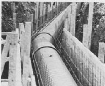
Abb. 29 Die verlegten Inlinerrohre DN 800 werden zum Verguß in Ortbeton vorbereitet
