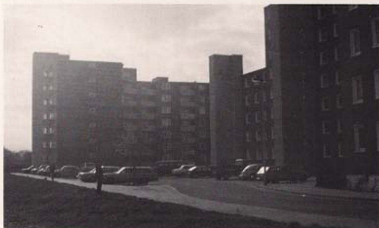
Abb. 1 Wohngebiet Schwerinstraße, Braunschweig
