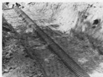
Abb. 8 Verlegung des Dynadur-Stegrohres® DN 630. Die Einbettung ist bis zum Rohrkämpfer erfolgt.
