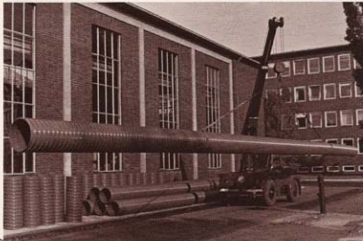
Abb. 1: 22,4 m lange Stegrohre DN 500 für eine Abwasserleitung
