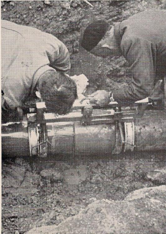
Bild 3: Herstellen einer Klebeverbindung bei DYNADUR-Rohren NW 250
