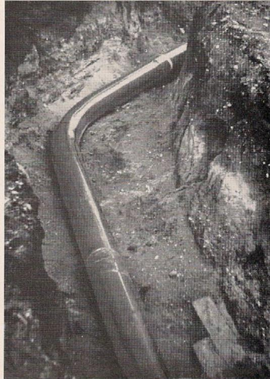
Bild 4: Auf der Baustelle hergestellter 40°-Bogen aus DYNADUR-Rohr NW 250
