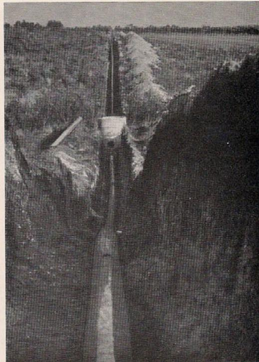
Bild 2: Entleerungsschacht an einem Tiefpunkt der Leitung
