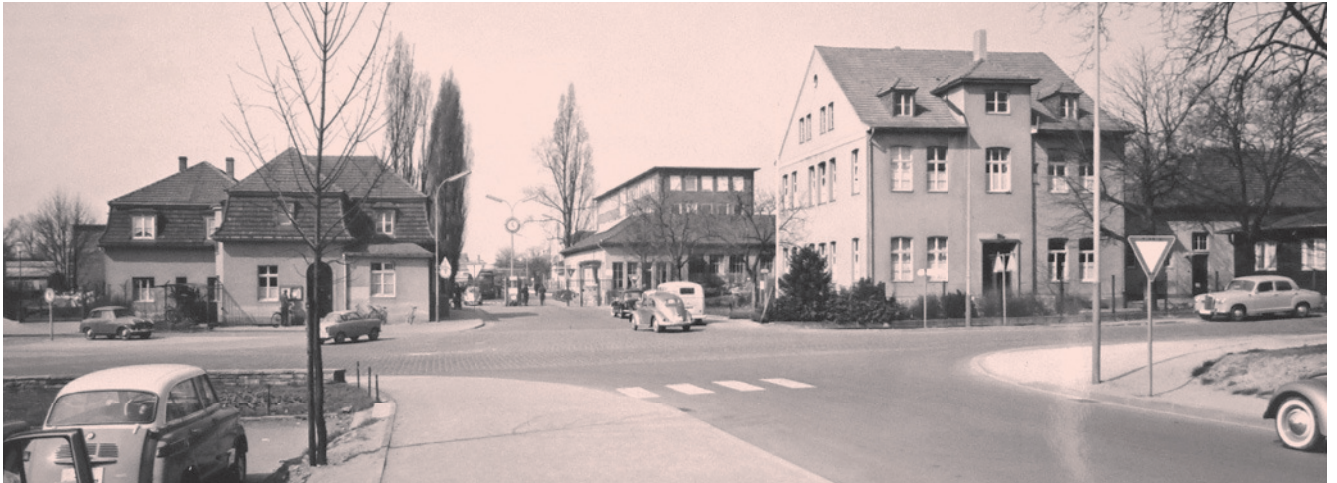
Das ehemalige Tor 1 wurde letztes Jahr zurückgebaut und existiert heute nicht mehr.
