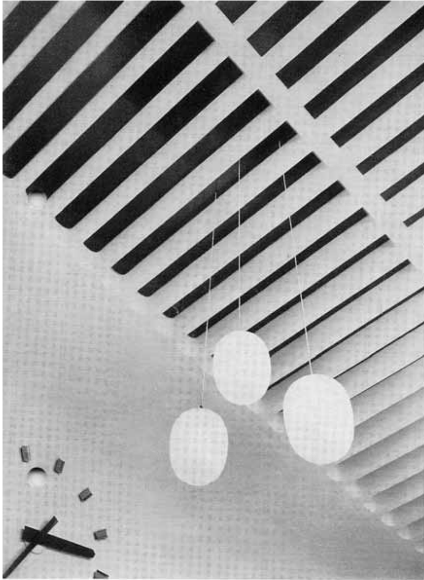
Deckenverkleidung in ULTRAPAS
