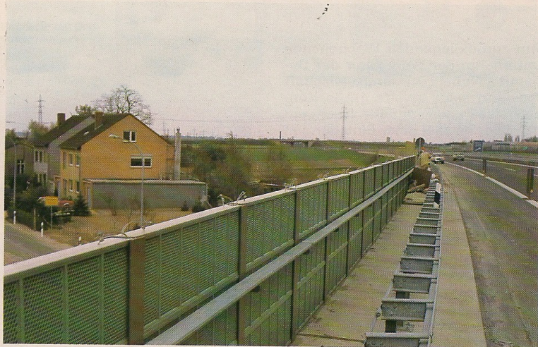
Schallschutzwände an Autobahnen halten lästigen Verkehrslärm von den Anwohnern fern. Unser Bild zeigt gelochte Frontelemente aus TROVIDUR® ESA an gerade montierten Schallschutzwänden.
