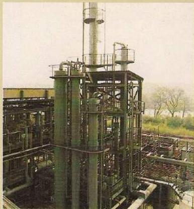
Destillationsanlage für Chlorsilane im Werk Rheinfelden
